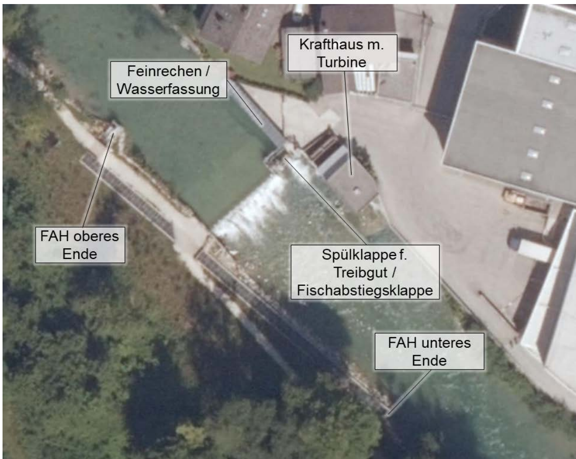
Abbildung 9: Ansicht Kraftwerk Ebewe und Anordnung relevanter Anlagenteile. Bildgrundlage: DORIS –Geodateninformationssystem Land Oberösterreich.
