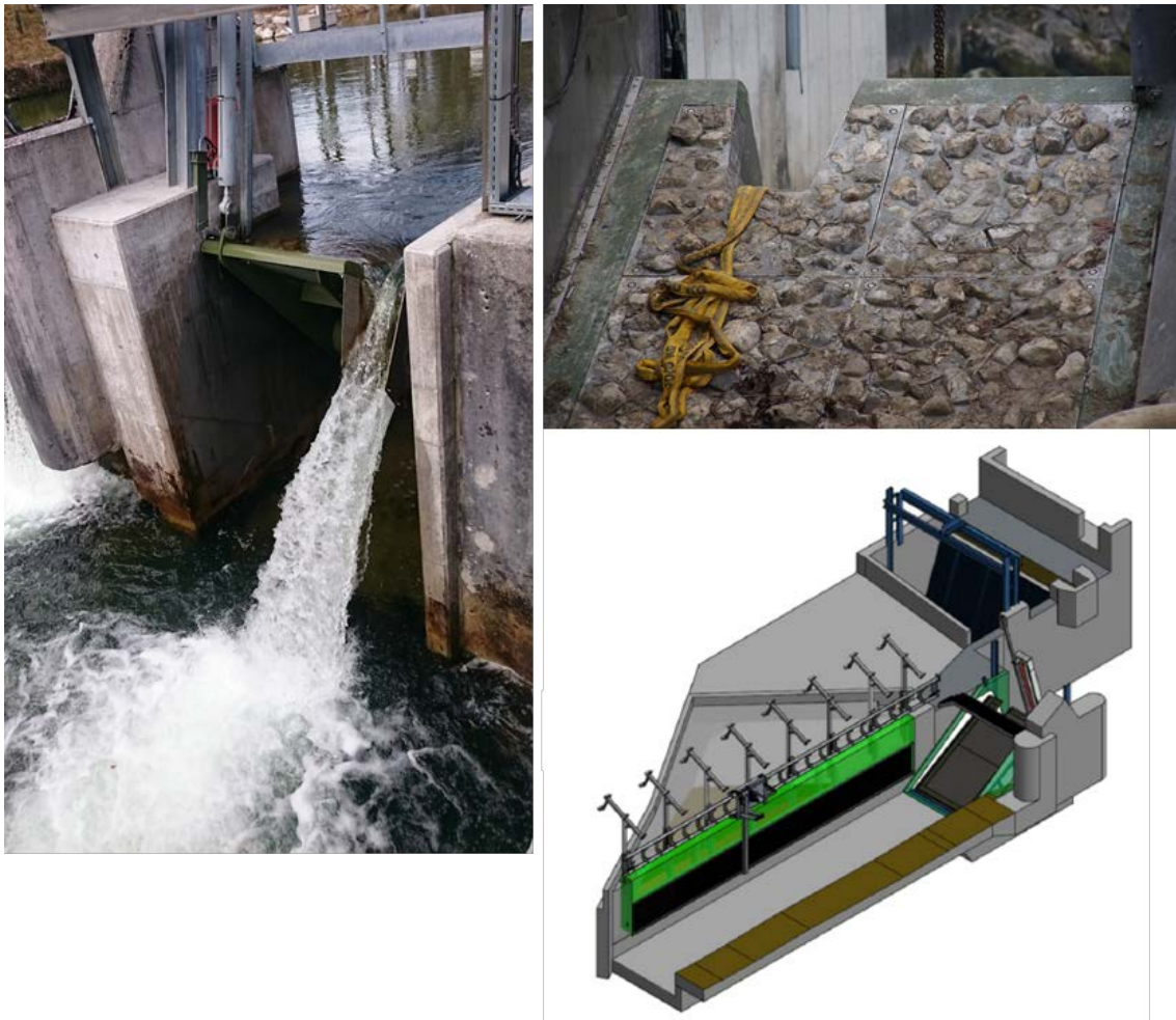
Abbildung 10: Treibgutklappe mit Fischabstiegsfunktion am Kraftwerk Ebewe. (Bild rechts oben: TB Blattfisch; rechts unten: Fa. Jank)
