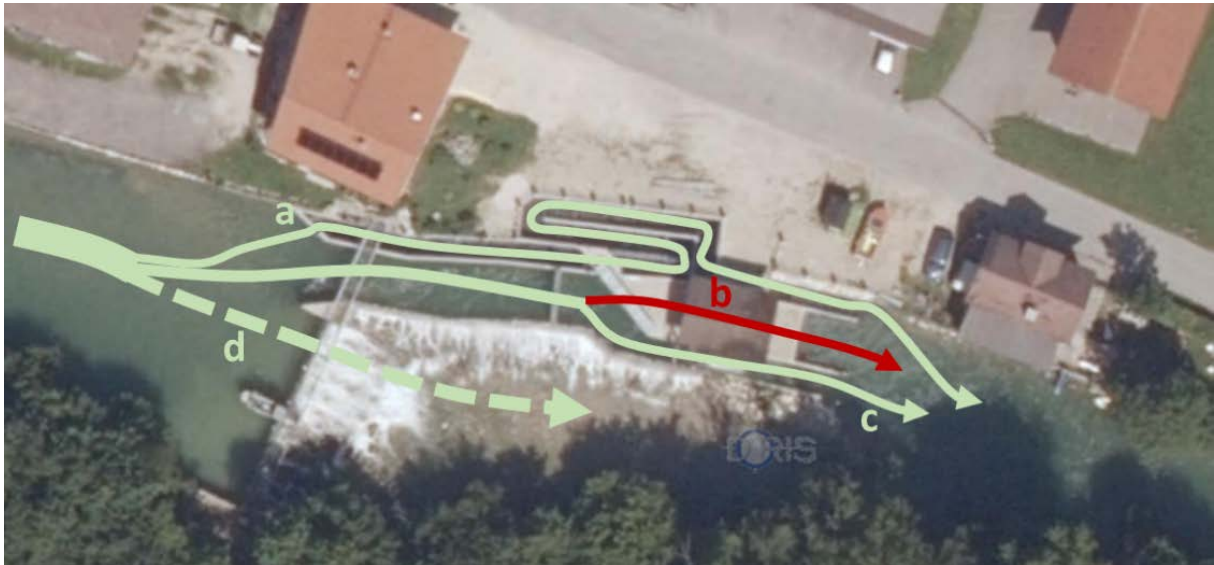
Abbildung 8: Verfügbare Abwanderkorridore am Kraftwerk Laganda. a) Fischaufstiegshilfe (für Auf- und Abstieg nutzbar), b) Turbine, c) Fischabstiegshilfe/Klappe und d) Wehr (nur bei erhöhtem Wasserstand). Bildgrundlage: DORIS –Geodateninformationssystem Land Oberösterreich.
